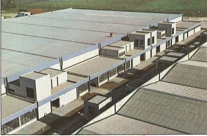
Tevsi inşaatımızdan bir görünüş.
